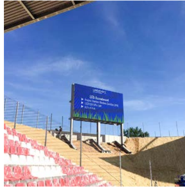
GGZ ARENA | Zwickau
